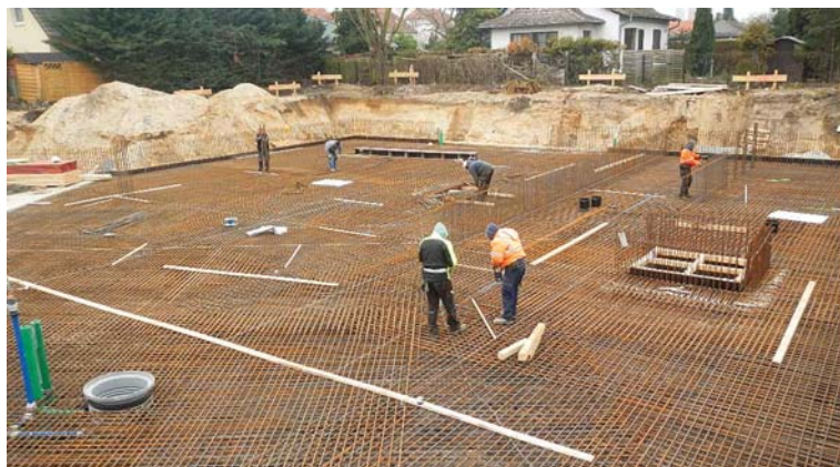
Armierung Bodenplatte
